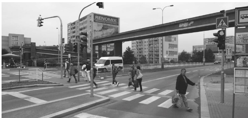
[ OBR. 12 ] Nevhodně řešené mimoúrovňové křížení pěšího pohybu s komunikací. Pro nefunkčnost byl nejprve paralelně zřízen úrovnový přechod a nakonec nadchod zcela odstraněn.
